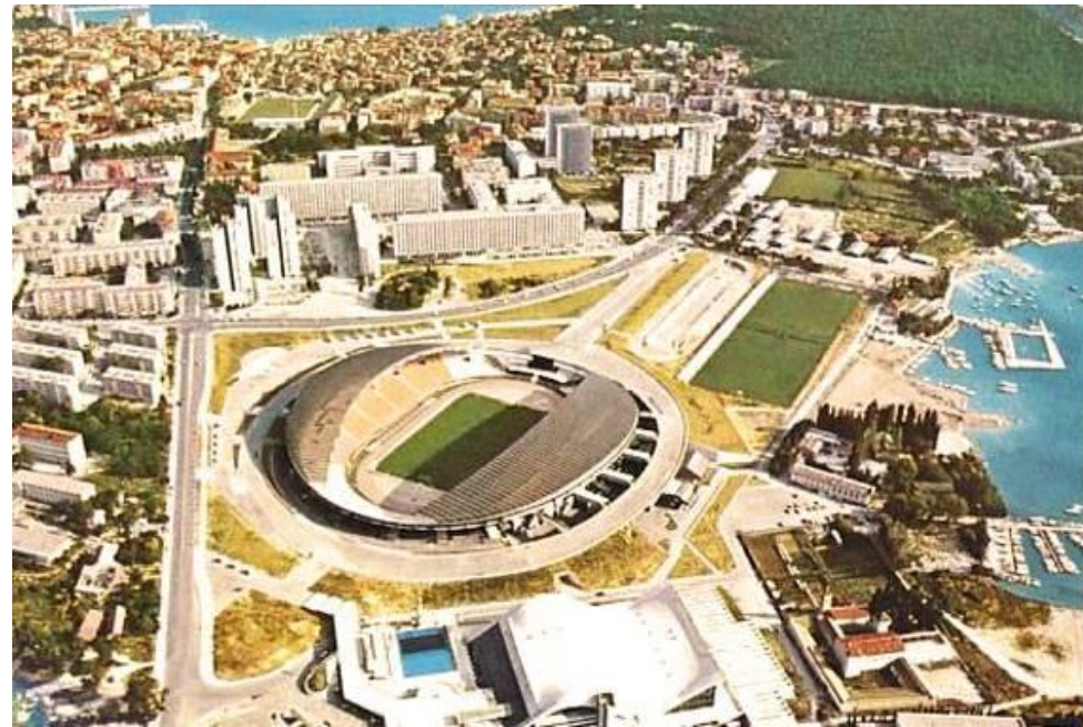
IZGRADNJA STADIONA 1979.GOD.
